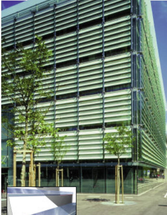
Tamedia Building, Zürich, Schweiz Fassadendesign: Soder AG, 2001 Verklebung von Glasstufen mit lackiertem Stahlrahmen.
