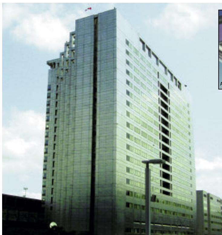
Samsung Medical Center, Seoul, South Korea Architekt: Samoo Architects and Engineers, 1995 Verklebung von Aluminiumprofilen mit Aluminiumplatten.
