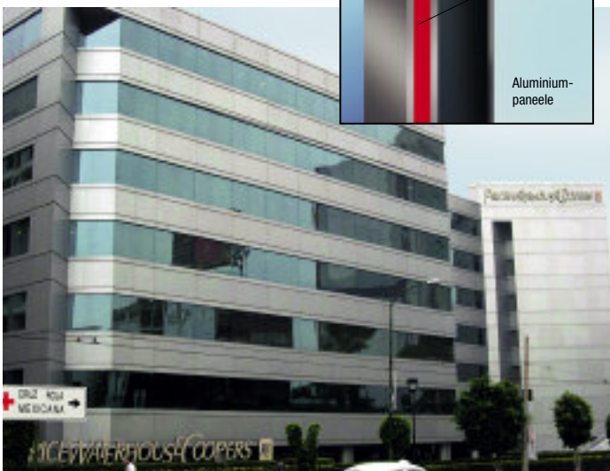
Price Waterhouse, Mexico City, Mexico Gebäude: Salvador Diaz Dupont, 2001 Verklebung von Aluminiumplatten mit Rahmen.
