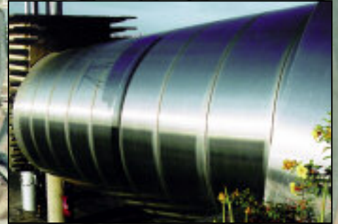
Aeroporto Fortaleza, Fortaleza, Brasilien Architekt: Claudio Silva, 1997 Verklebung von Edelstahlplatten auf Stahlrahmenkonstruktion.
