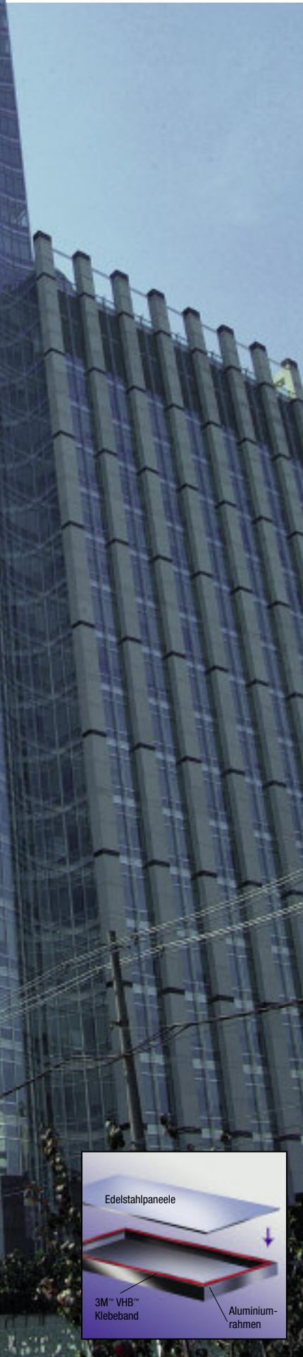
Samsung Medical Center, Seoul, South Korea Architekt: Samoo Architects and Engineers, 1995 Verklebung von Aluminiumprofilen mit Aluminiumplatten.
