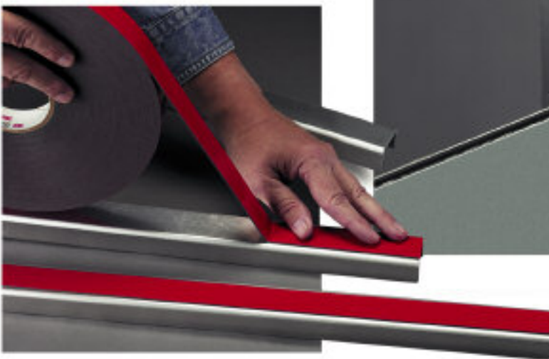
das VHB Klebeband aufbringen und andrücken
