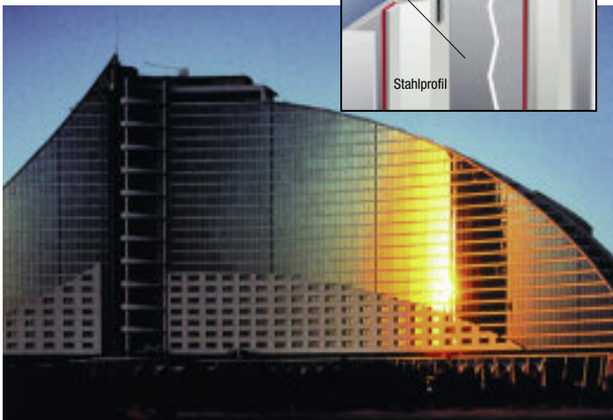
Jumeirah Beach Hotel, Dubai, Vereinigte Arabische Emirate Projektausführung: Schmidlin AG, 1998 Verklebung von Alusandwich-Fassadenelementen auf Stahlprofilen
