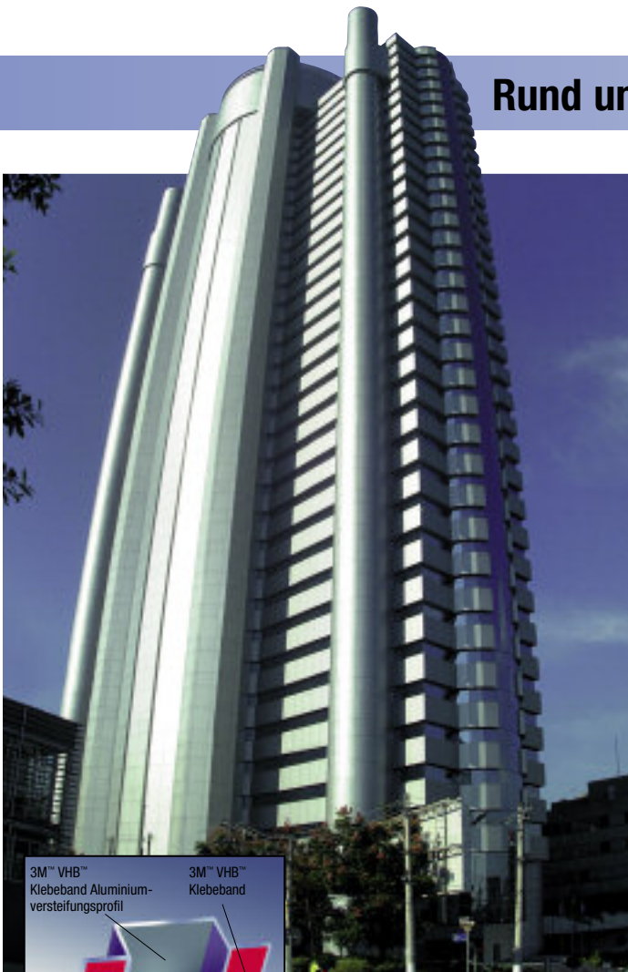
Plaza Centenário, Sao Paulo, Brasilien Architekt: Carlos Bratke, 1995 Verklebung von Aluminiumversteifungen mit Aluminiumverbund-Platten.
