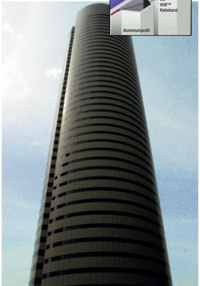
Temasek Tower, Singapur Architekt: Architects 61, 1985 Verklebung von Aluminiumversteifungsprofilen mit Fassadenelementen.
